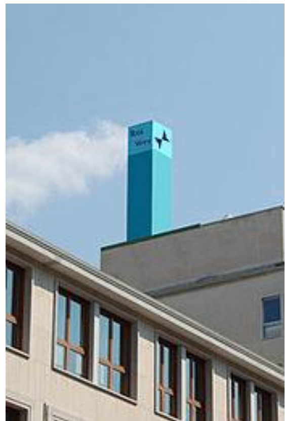
Figura 10 - stazione radio base mimetizzata tramite pannellatura – www.calzavara.it
