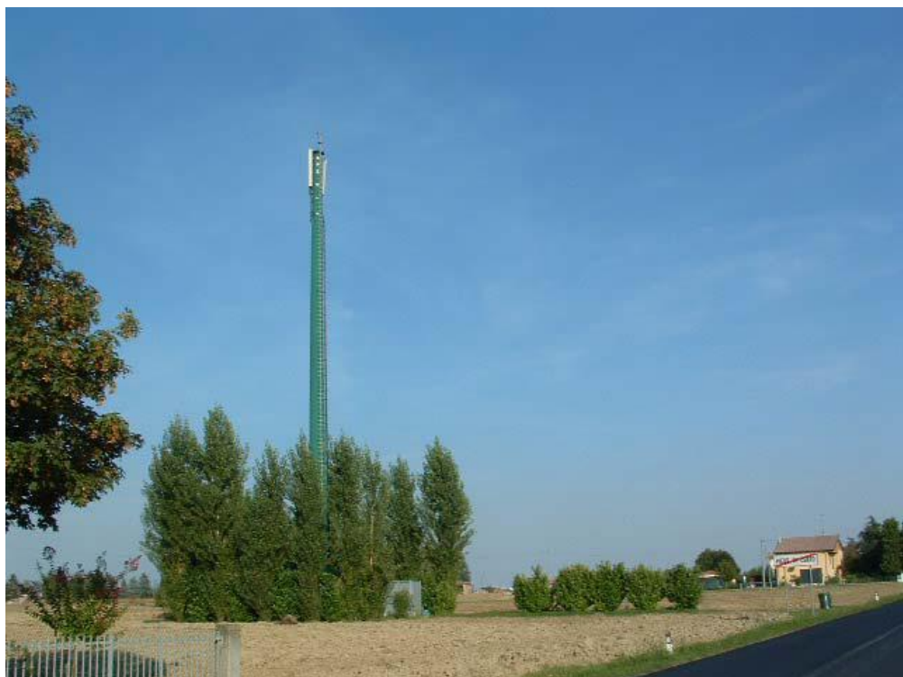
Figura 5 - esempi mitigazione shelter, palo e viabilità in ambito agricolo
