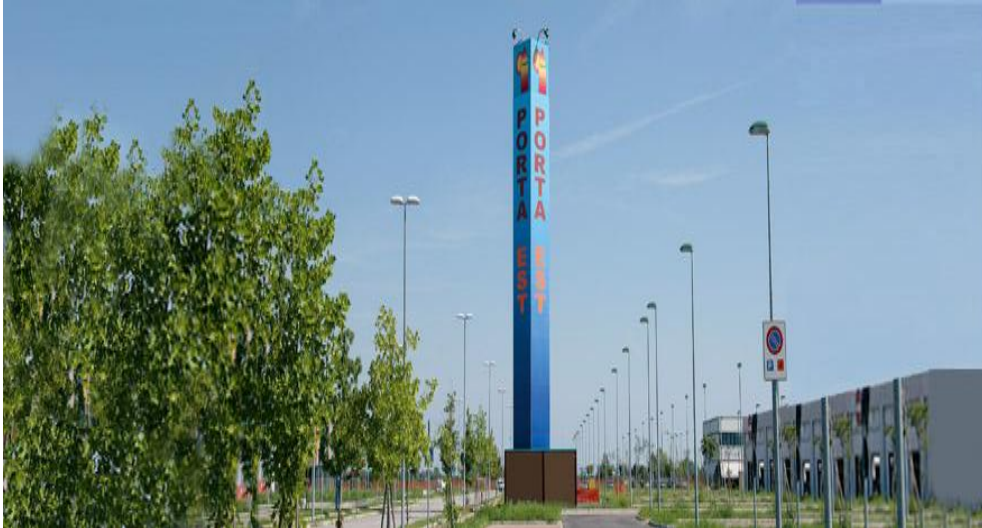
Figura 16 - torre pubblicitaria a mascheramento antenne - www.calzavara.it
