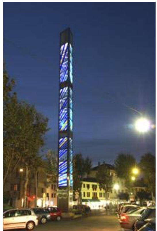
Figura 8 - struttura rivestita da pannelli in vetrocamera, riempita da tessere in vetro di Murano, che vanno a creare un mosaico sui toni fra il verde e l'azzurro, piazza Matteotti, Treviso
